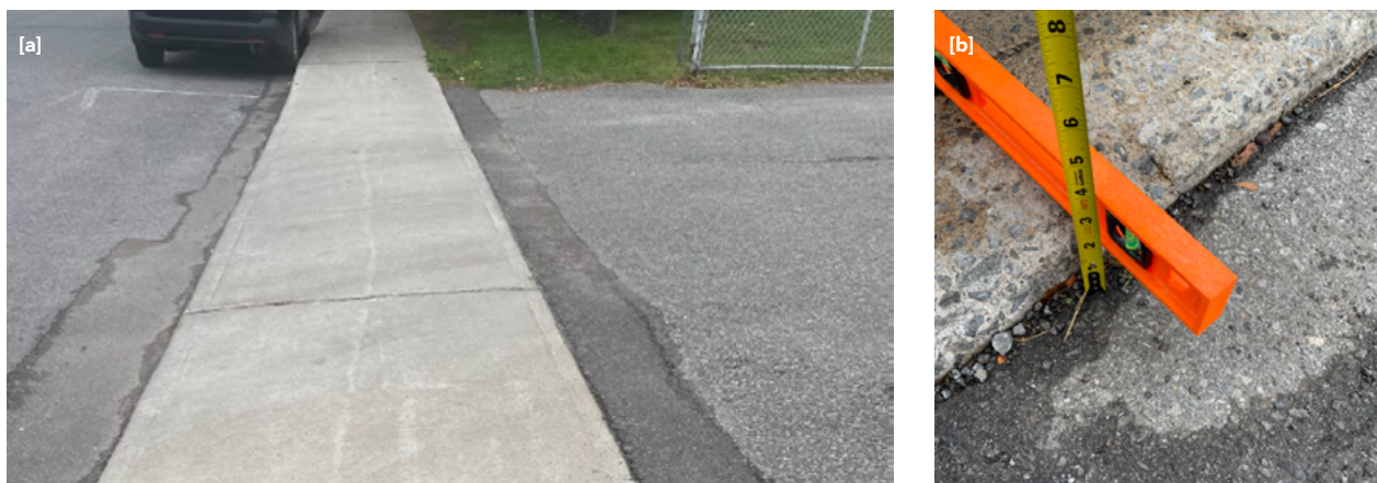
FIGURE 1 | ILLUSTRATION DU BATEAU-PAVÉ À LA BIBLIOTHÈQUE DE SAINT-MICHEL DANS L'ARRONDISSEMENT DE VILLERAY-SAINT-MICHEL-PARC-EXTENSION COMPARATIVEMENT À UN BATEAU-PAVÉ SUFFISAMMENT ABAISSÉ AU CHALET DU PARC DALBÉ-VIAU DANS L'ARRONDISSEMENT DE LACHINE
